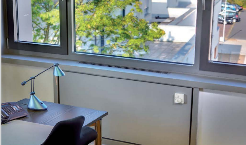
用于混合通风的LG-ZA-M-SB通风装置(送风/回风) 垂直矮墙安装
