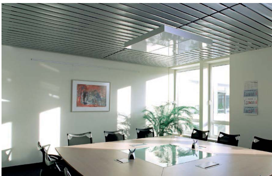
静态冷却天花板系统SKS-5/3, 用于可视安装
